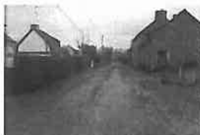
Gravillonnage réalisé au Village de Launay
